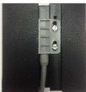
Sensor de Fluxo utilizado para instalações em Zona 1, EPL Gb é instalado na válvula de alívio (V-RV-0) e garante que o fluxo de saída do gás de proteção do invólucro durante o processo de purga esteja conforme a especificação.
