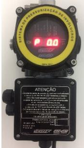
Unidade de processamento baseada em microcontrolador, responsável pelo controle, proteção e monitoração das variáveis de pressão, vazão e tempo tomando todas as ações para manter o invólucro a ser pressurizado dentro das condições de segurança prescritos nas normas ABNT NBR IEC 60079-2:2016.
