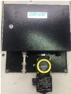
Este componente além de agregar a unidade de processamento (V-PU-1) contempla outras partes que compõe o sistema de pressurização específico para grandes invólucros e máquinas girantes.
